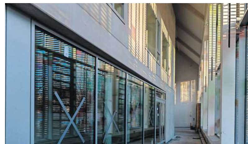
Das „Haus im Haus“: In die Außenwände der ehemaligen Orangerie wurde ein zweites Gebäude mit modernen Büros gesetzt.
